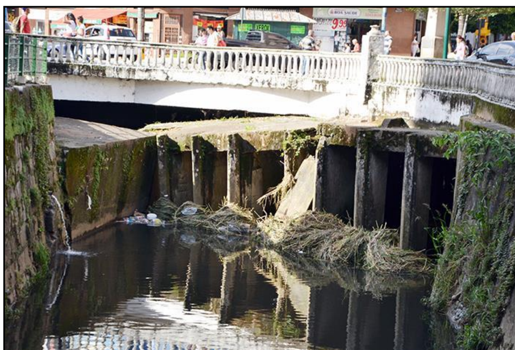
Foto 9-9 - Tomada do Túnel Extravasor do Rio Palatinato Obstruída
