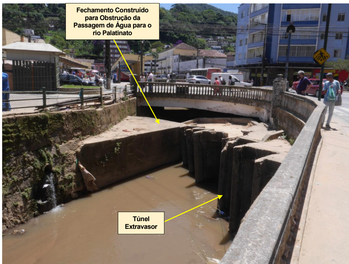
Foto - 11-12 - Tomada D’Água do Túnel Extravasor em abril de 2022
