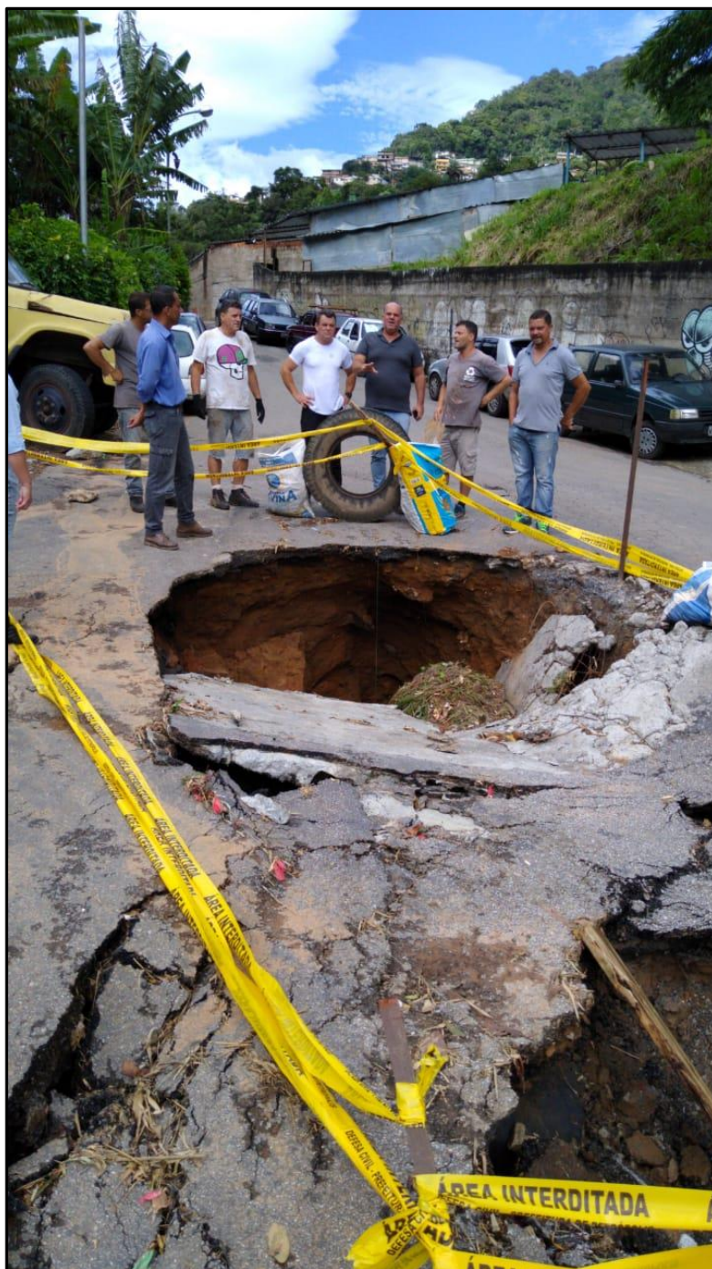
Foto - 11-13 - Trecho do Túnel Extravisor na Rua do Túnel Danificado em 2021
